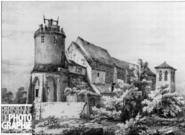
Le télégraphe optique de Chappe à Montmartre installé sur le chevet de l'église Saint-Pierre, à Paris, en 1824. Lithographie de C. Motte d'après J. Jacottet. B.N.
