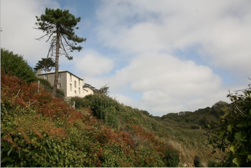
Au loin, locaux techniques de la station de Déolen
