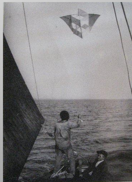
Le cerf volant supportant l'antenne TSF
